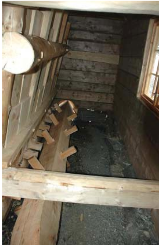
Denne kraftige akslingen med hakar løfter dei tunge tømmerstokkane og slepper dei ned i «bryå» der kledet ligg.
